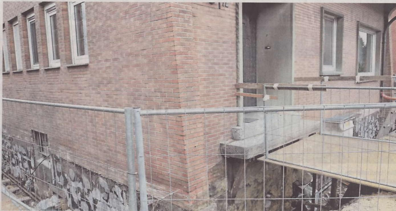
Das Haus von Hans und Renate Balster ist ein Beispiel für den hohen Aufwand, der mit einer Verbolzung einhergeht. Sie wird vor dem Abbau untertage vorgenommen, um später gesicherte Messdaten über die Schiefelage zu erhalten.
