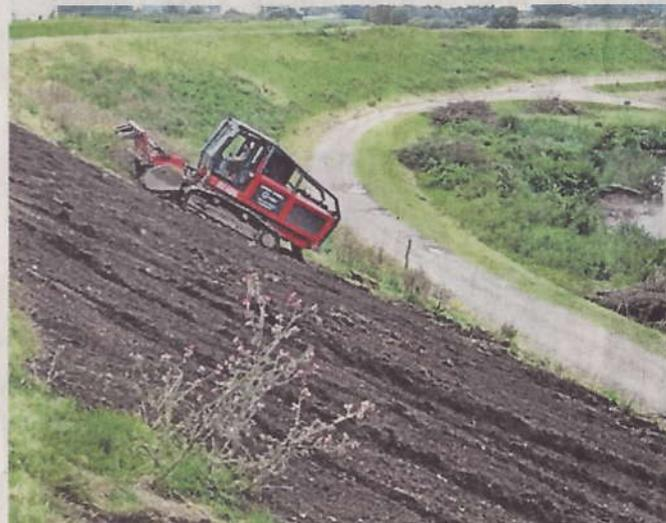
**Am alten Deich werden nach den Fäll- und Rodungsarbeiten Wurzeln und Grasnarbe entfernt.**
